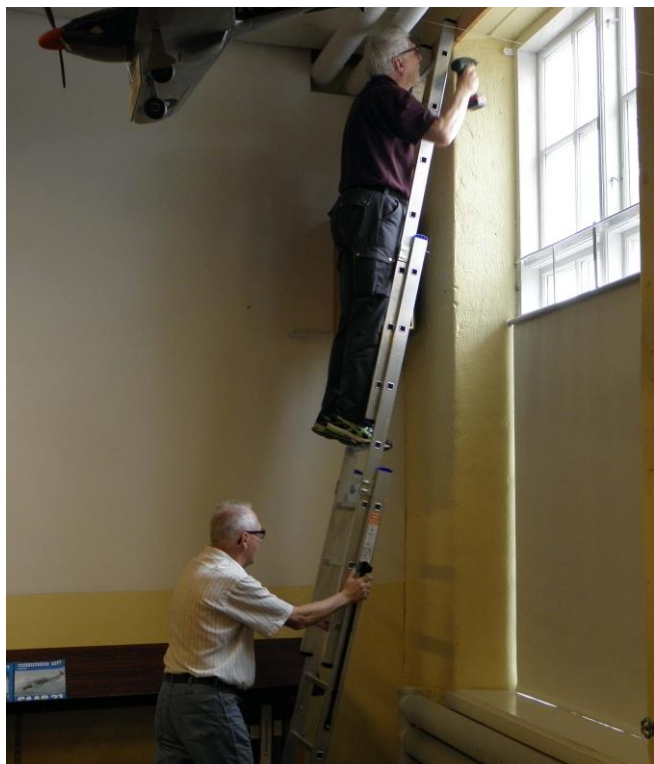
Montering av rullgardiner för att kunna mörklägga i visningslokalen. Samtidigt putsas fönstren.
